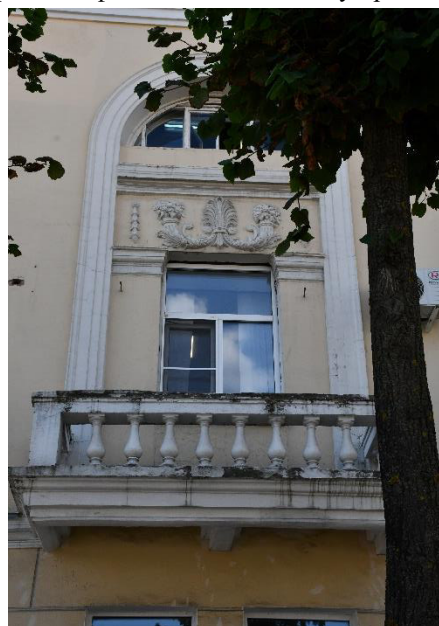
Фрагмент фасада по Ленинскому проспекту.
