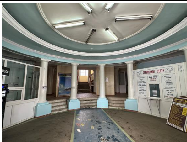
Фрагмент интерьера, вестибюль.
