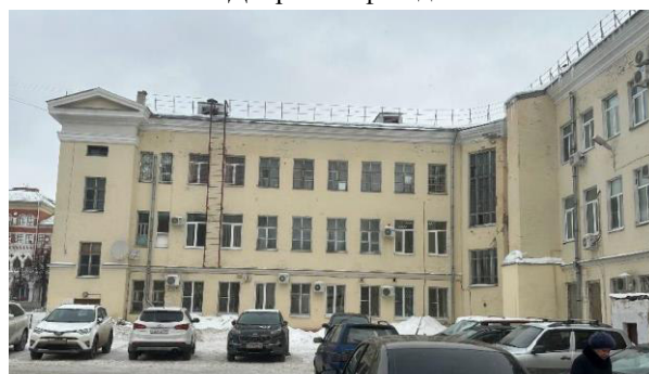
Фрагмент дворового фасада.
