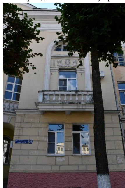
Фрагмент фасада по Ленинскому проспекту.
