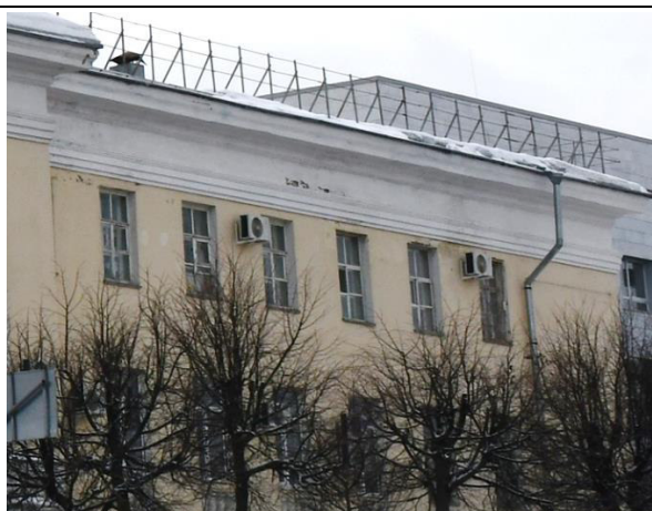
Фрагмент фасада по Ленинскому проспекту.
