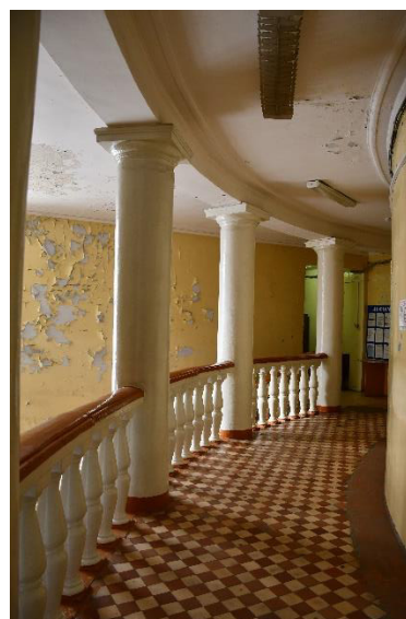
Фрагмент интерьера 3-го этажа.
