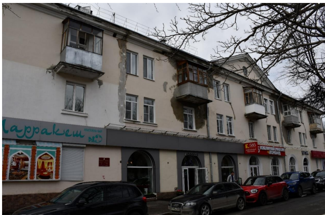
Фото 2 ОКН «Дом жилой, 1960 г.». Главный (северо-восточный) фасад.
