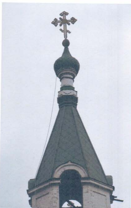
Фото 5. ОКН «Церковь святителя Николая Чудотворца». Фрагменты западного фасада. Повреждение обмазки в результате атмосферных воздействий, наличие ржавчины на поверхности кровли, шелушение и отслоение окрасочного слоя, фиксируется ослабление части оттяжек крестов на главках четверика, отклонение части крестов от вертикали.
