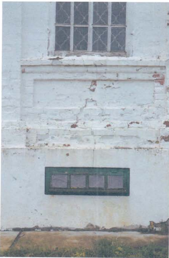
Фото 7. ОКН «Церковь святителя Николая Чудотворца». Фрагменты восточного фасада. Наличие трещин в подоконных частях стен, повреждение обмазки в результате атмосферных воздействий, частично отсутствуют звенья водосточных труб, водосборные воронки и отметы (сливное колено), на локальных участках деформация водосточных труб и желобов.
