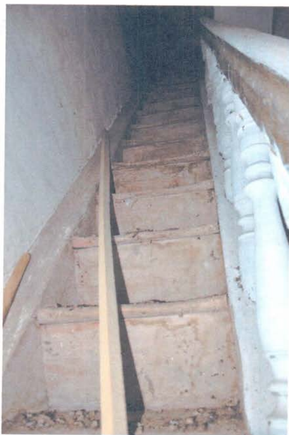
Фото 14. ОКН «Церковь святителя Николая Чудотворца». Фрагменты интерьера (притвор). лестница – деревянные на тетивах, ограждения деревянные (на первый ярус – балясины, на верхние ярусы – глухие), состояние удовлетворительное.
