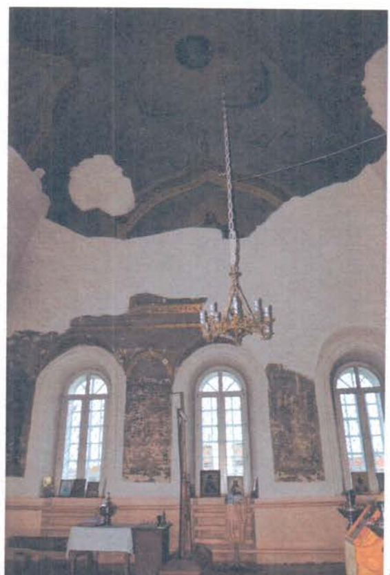
а) б) Фото 20. ОКН «Церковь святителя Николая Чудотворца». Фрагменты интерьера (трапезная). Сохранились фрагменты росписей сводов и стен, состояние неудовлетворительное, утраты, разрушения красочного слоя, красочный слой шелушится, наблюдаются вспучивания и отставания красочного слоя от основы, утраты штукатурного и окрасочного слоев.
