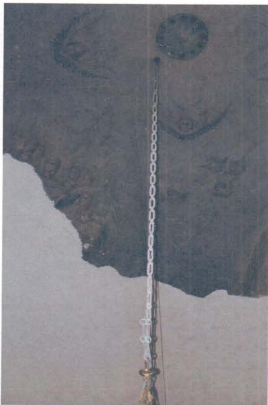
а) б) Фото 20. ОКН «Церковь святителя Николая Чудотворца». Фрагменты интерьера (трапезная). Сохранились фрагменты росписей сводов и стен, состояние неудовлетворительное, утраты, разрушения красочного слоя, красочный слой шелушится, наблюдаются вспучивания и отставания красочного слоя от основы, утраты штукатурного и окрасочного слоев.
