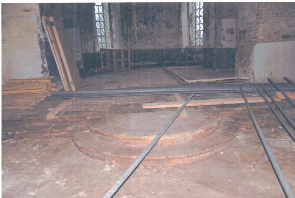
Фото 27. ОКН «Церковь святителя Николая Чудотворца». Фрагмент интерьера (четверик). Полы каменные (предположительно из известковых плит), солеи (центральная и боковые в пределах) из керамического кирпича, покрытие каменное (предположительно из известковых плит), состояние неудовлетворительное, растрескивание плит, сколы, небольшие утраты.
