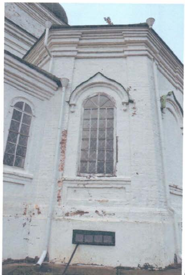
Фото 7. ОКН «Церковь святителя Николая Чудотворца». Фрагменты восточного фасада. Наличие трещин в подоконных частях стен, повреждение обмазки в результате атмосферных воздействий, частично отсутствуют звенья водосточных труб, водосборные воронки и отметы (сливное колено), на локальных участках деформация водосточных труб и желобов.
