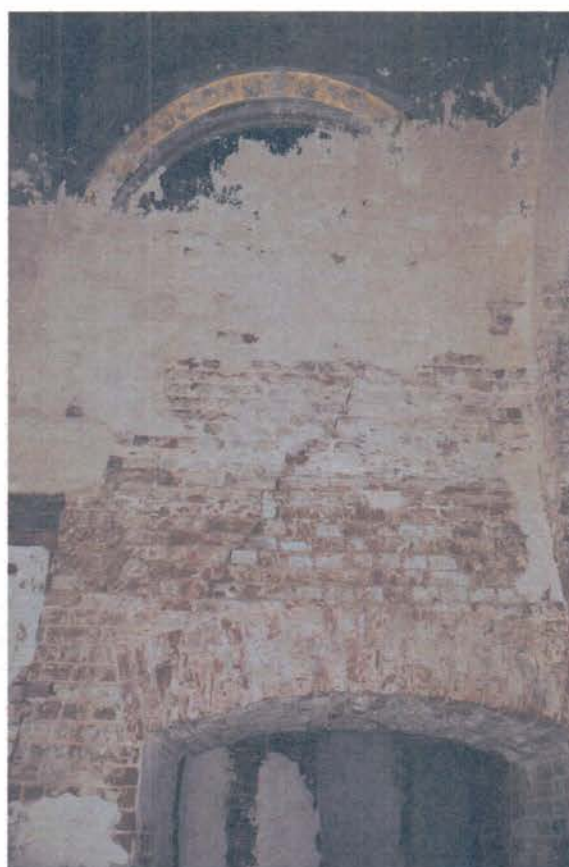
Фото 28. ОКН «Церковь святителя Николая Чудотворца». Фрагменты интерьера (апсида алтаря). Наличие трещин в летнем храме, на локальных участках фиксируется увлажнение и биопоражение (мох, плесень) нижней части стен, небольшие механические повреждения кладки алтаря, множественные трещины в штукатурном слое, утраты и отслоение штукатурного слоя.
