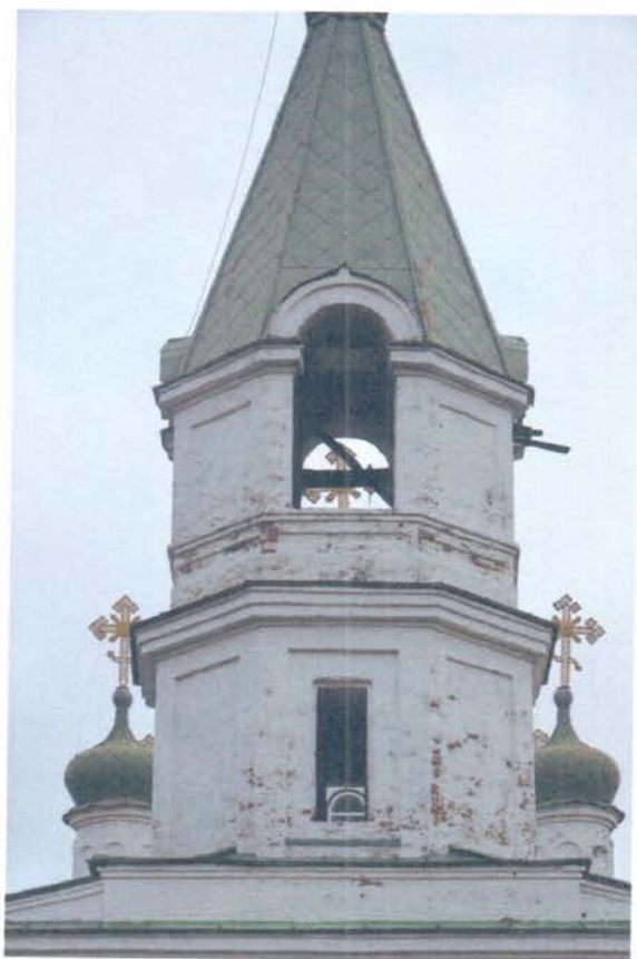
Фото 5. ОКН «Церковь святителя Николая Чудотворца». Фрагменты западного фасада. Повреждение обмазки в результате атмосферных воздействий, наличие ржавчины на поверхности кровли, шелушение и отслоение окрасочного слоя, фиксируется ослабление части оттяжек крестов на главках четверика, отклонение части крестов от вертикали.
