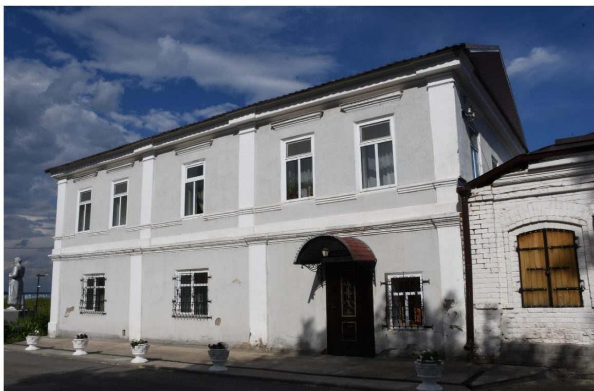
Фото 4. ОКН «Дом жилой», XIX в. Западный фасад.
