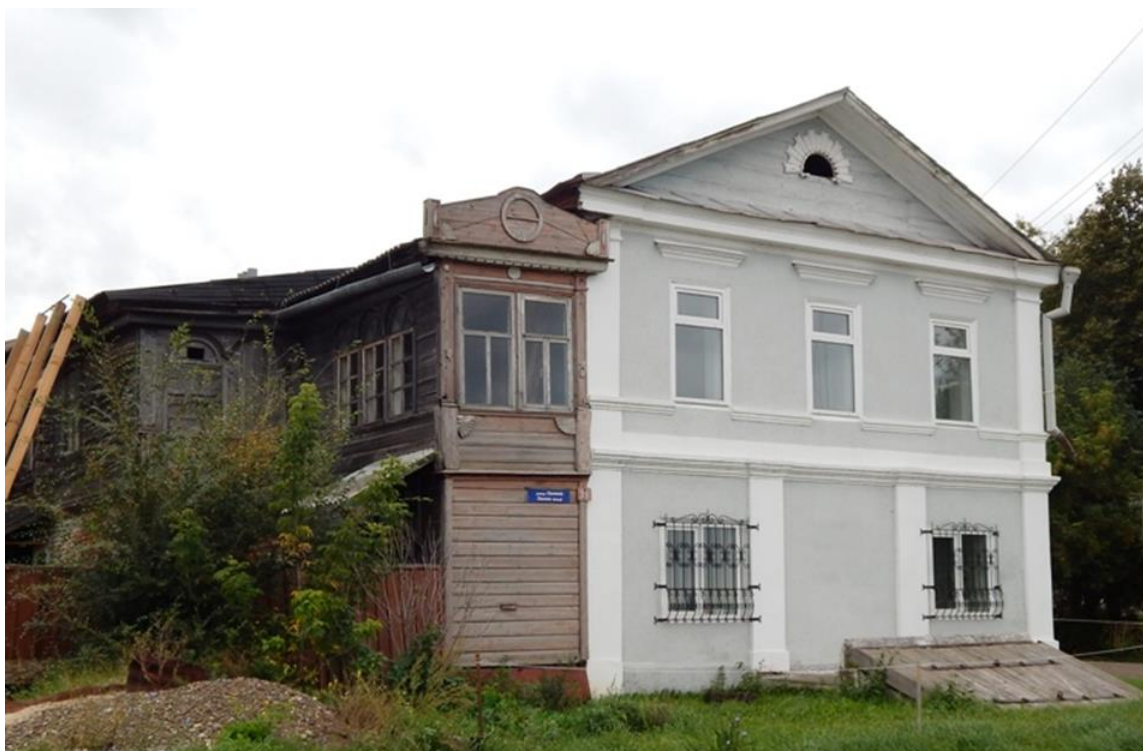
Фото 1. ОКН «Дом жилой», XIX в. Вид на объект с улицы Ленина. Фото 13.09.2014.
