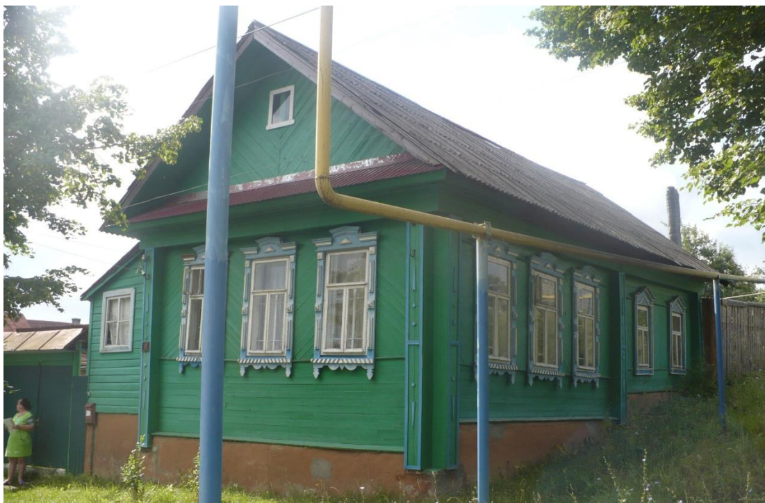
Фото 1. ОКН «Дом жилой, XIX в.». Вид на объект с северо-запада, 26.07.2012.
