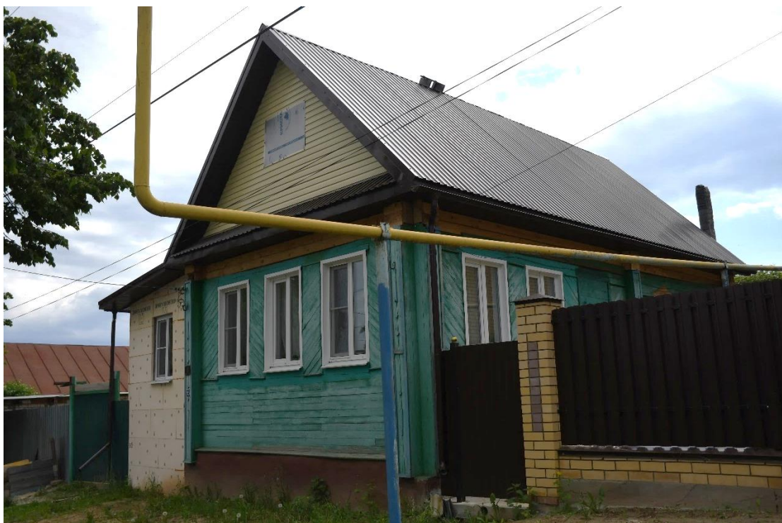
Фото 2. ОКН «Дом жилой, XIX в.». Вид на объект с северо-запада.
