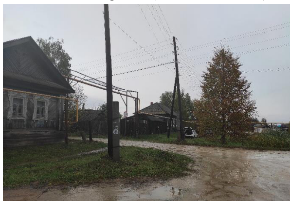
Вид на объект с юго-востока.
