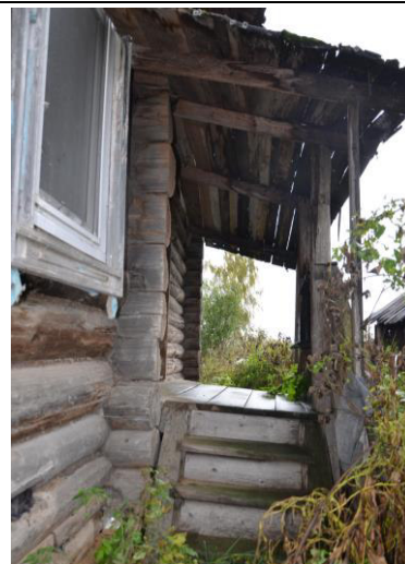
Крыльцо; вид с востока.
