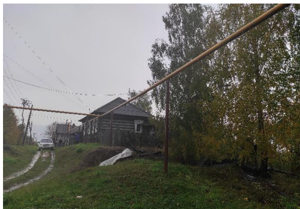
Вид на объект с северо-востока.
