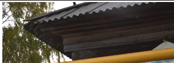
Фрагмент восточного фасада.
