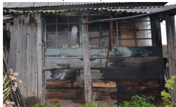
Крыльцо пристроя; вид с запада.
