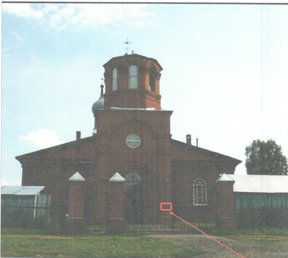
фото фасада с привязкой к месту установления информационной надписи
