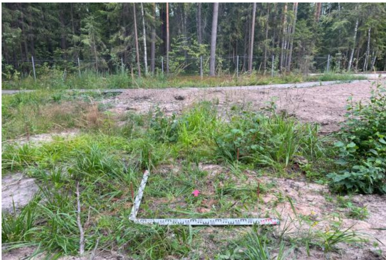
Рис.14. «Строительство ИЖС на территории Звениговского района, городское поселение Красногорский, пос. Илеть, ул. Сосновая Республики Марий Эл». Фото места закладки шурфа №1. Вид с юга.
