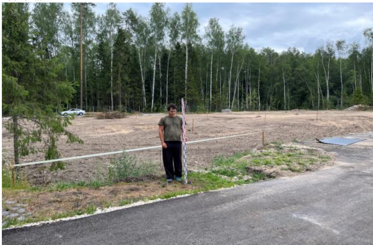
Рис.13. «Строительство ИЖС на территории Звениговского района, городское поселение Красногорский, пос. Илеть, ул. Сосновая Республики Марий Эл». Фото северо-восточной части участка обследования. Вид с юго-запада.
