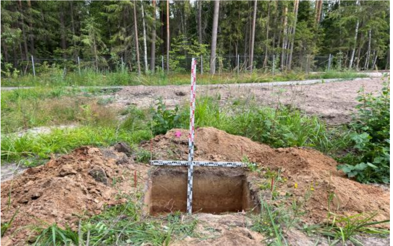
Рис.16. «Строительство ИЖС на территории Звениговского района, городское поселение Красногорский, пос. Иletz, ул. Сосновая Республики Марий Эл». Фото общего вида шурфа №1. Вид с юга.
