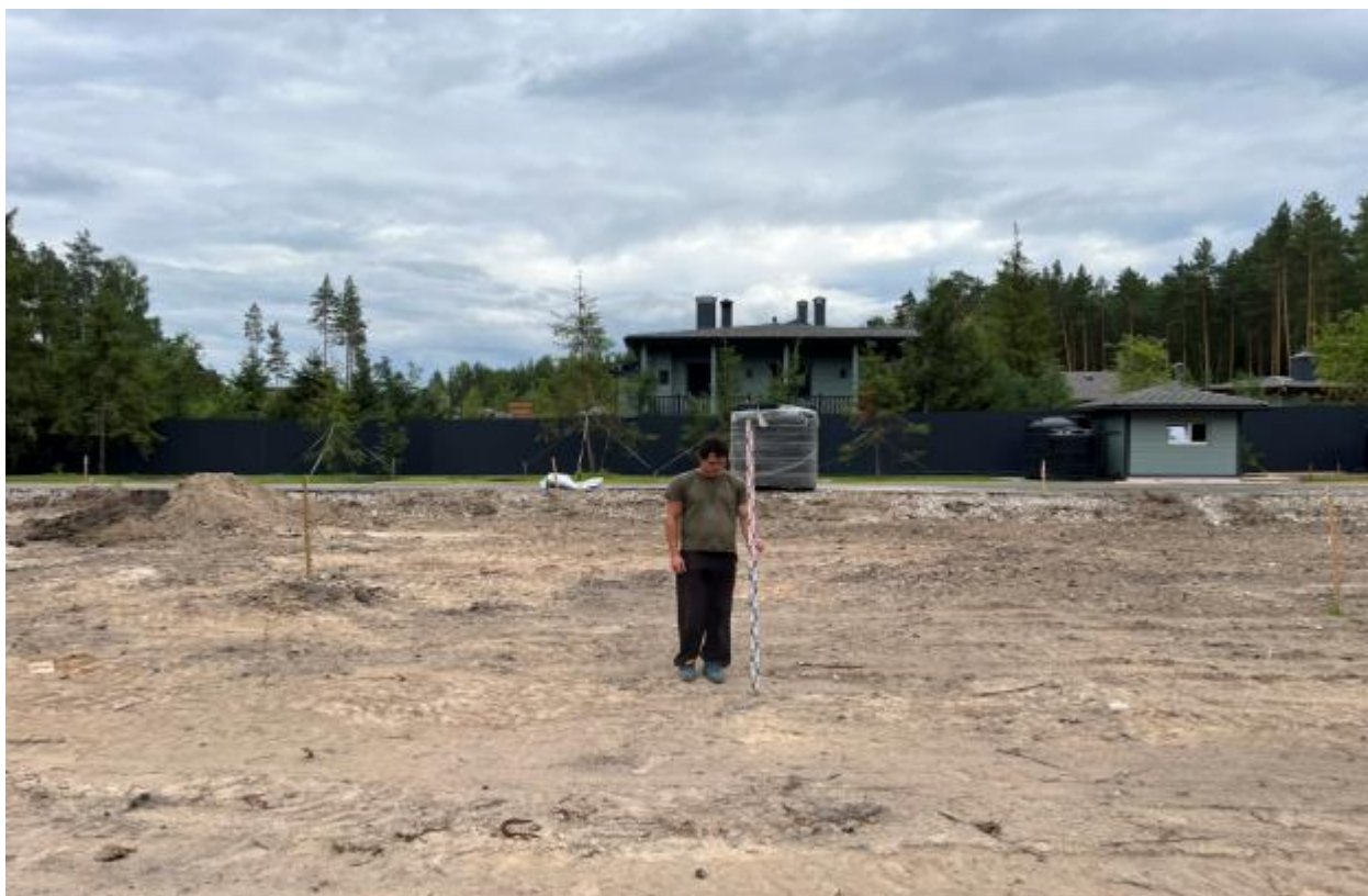
Рис.8. «Строительство ИЖС на территории Звениговского района, городское поселение Красногорский, пос. Илеть, ул. Сосновая Республики Марий Эл». Фото южной части участка обследования. Вид с севера.
