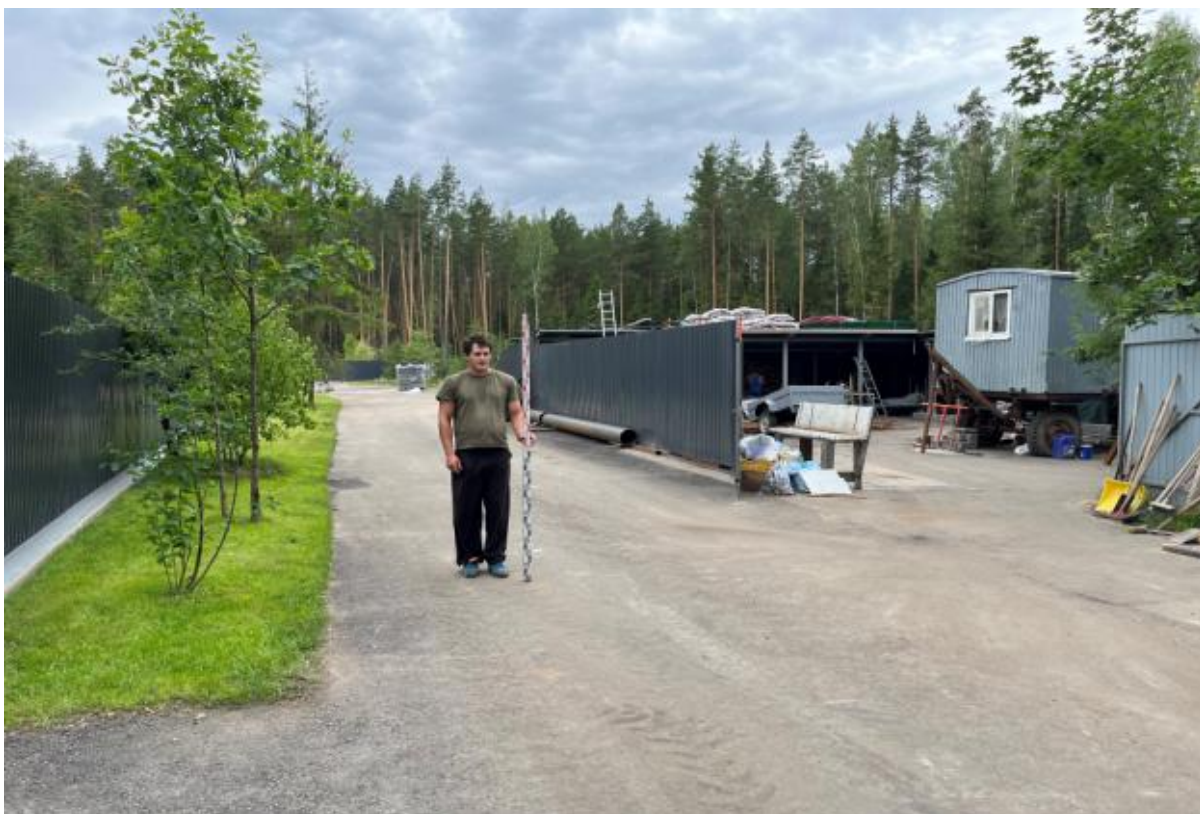
Рис.12. «Строительство ИЖС на территории Звениговского района, городское поселение Красногорский, пос. Илеть, ул. Сосновая Республики Марий Эл». Фото северо-западной части участка обследования. Вид с юго-востока.
