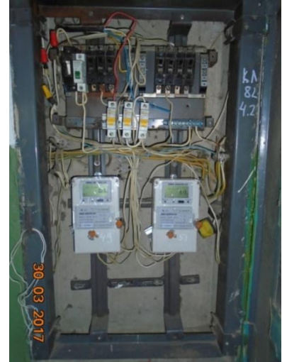
После установки системы
