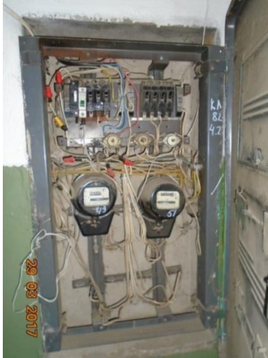
До установки системы
