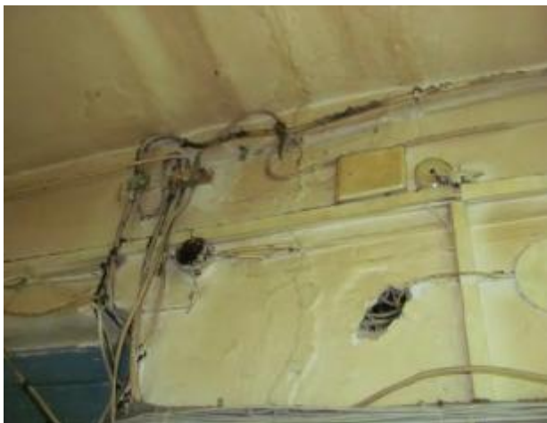
До установки системы
