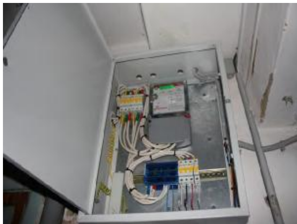
После установки системы
