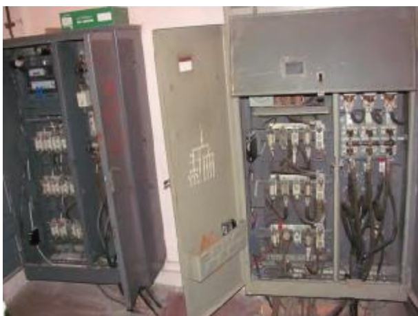
До установки системы
