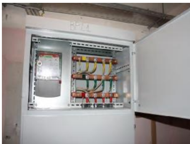
После установки системы
