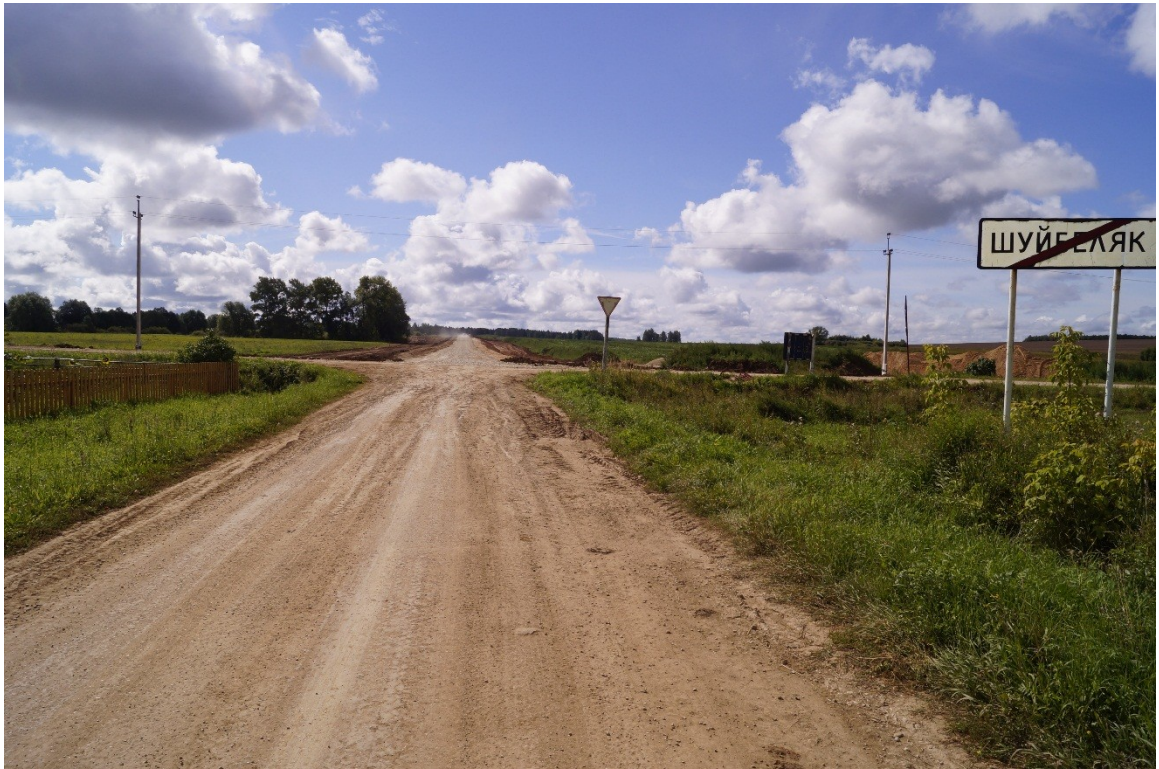
Фото 3. Автомобильная дорога Шуйбеляк – Шемермучаш Новоторъяльского района Республики Марий Эл (до начала строительства)
