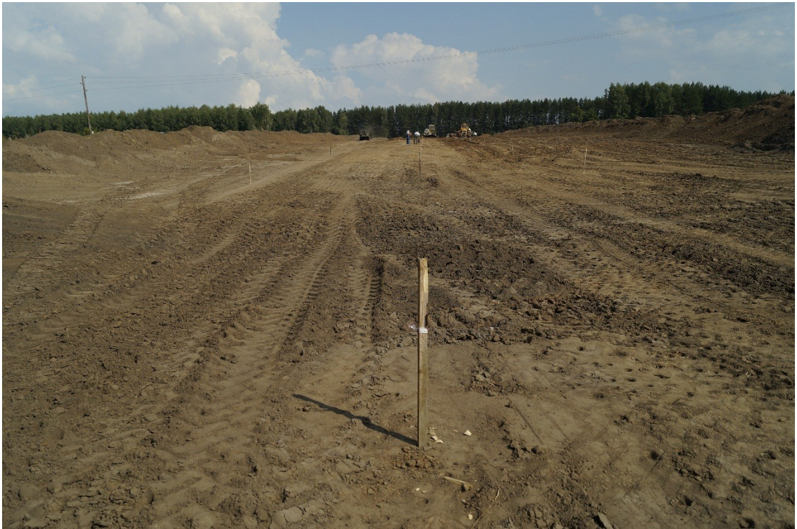
Фото 5. Автомобильная дорога Подъезд к д. Когаркино Горномарийского района (до начала строительства)
