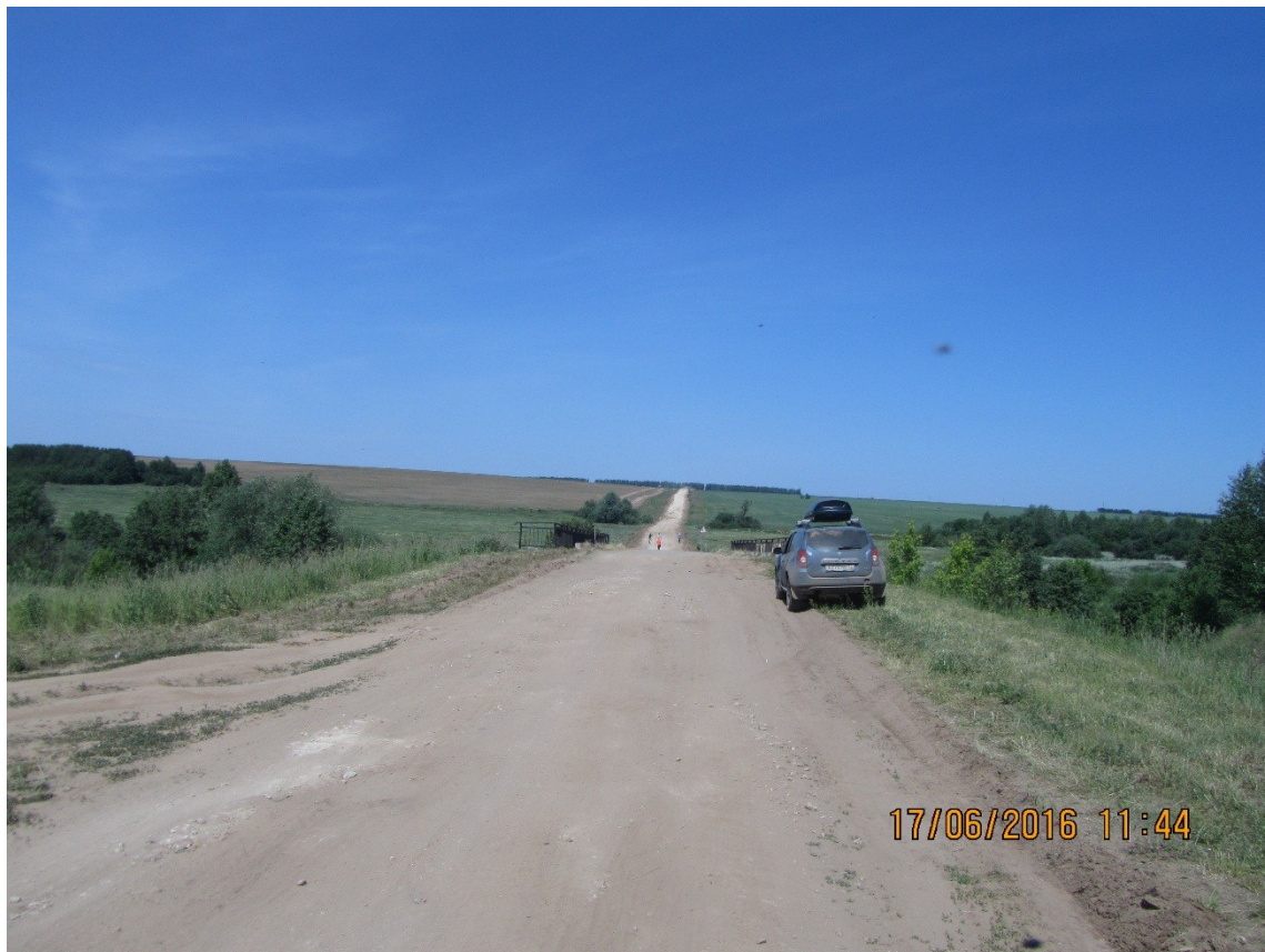
Фото 1. Автомобильная дорога Тат – Китня – Тат-Шолкер – Мари-Шолкер Мари – Турекского района (до начала строительства)
