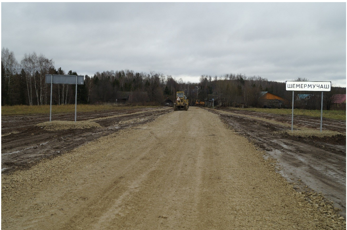
Фото 4. Автомобильная дорога Шуйбеляк – Шемермучаш Новоторъяльского района Республики Марий Эл (покрытие - щебень)
