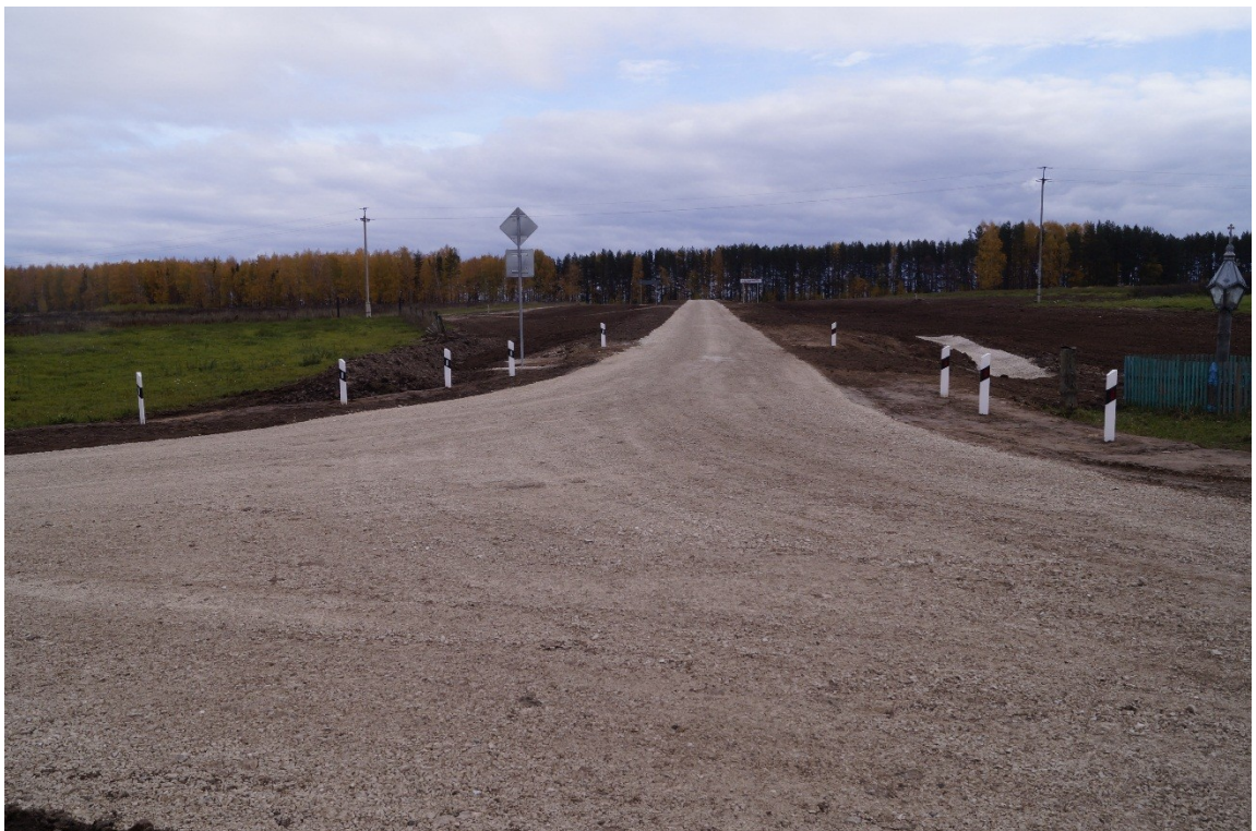
Фото 6. Автомобильная дорога Подъезд к д. Когаркино Горномарийского района (покрытие - щебень)
