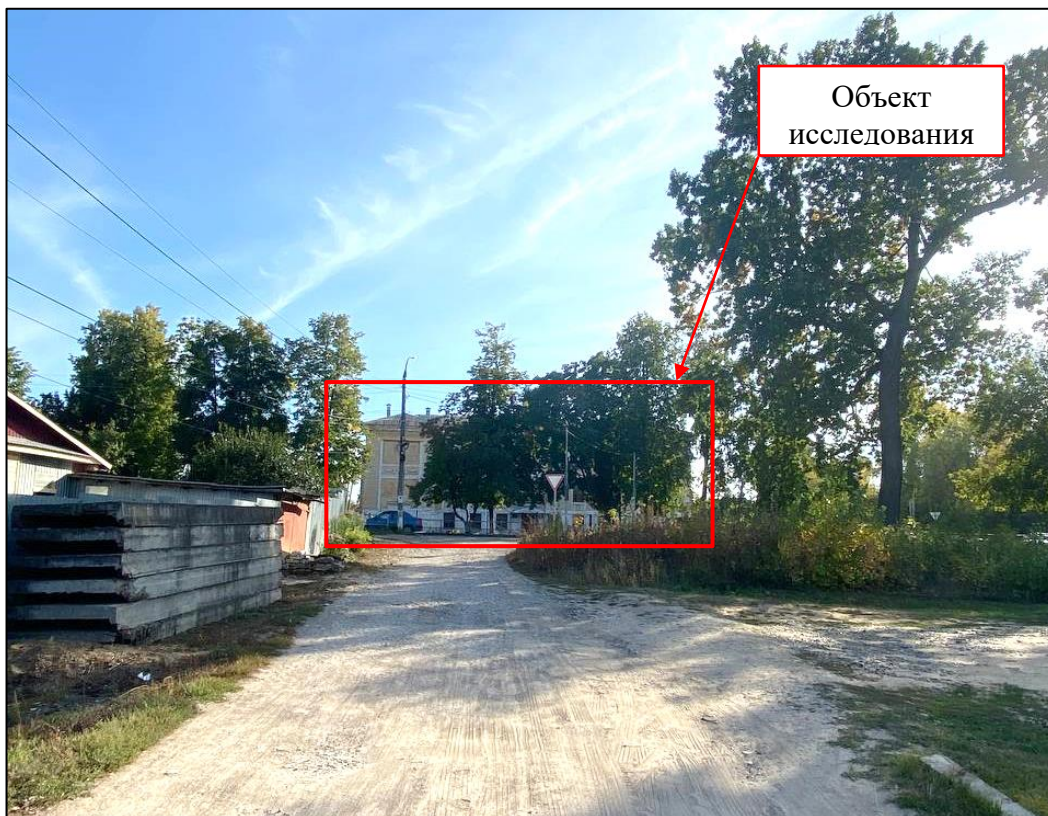
Видовая точка № 3. Удаленный вид на ОКН «Здание школы № 3» с ул. 1-я Дубовая с северо-восточной стороны.
