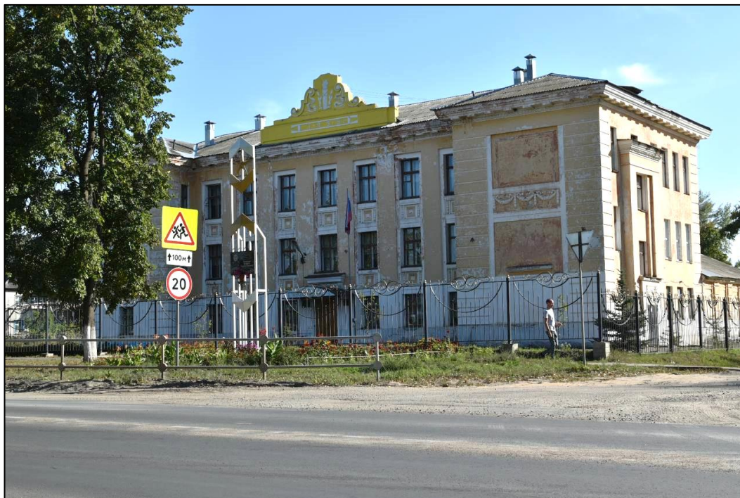
Видовая точка № 1. Вид на главный фасад ОКН «Здание школы № 3» по ул. Кошкина с северо-западной стороны.
