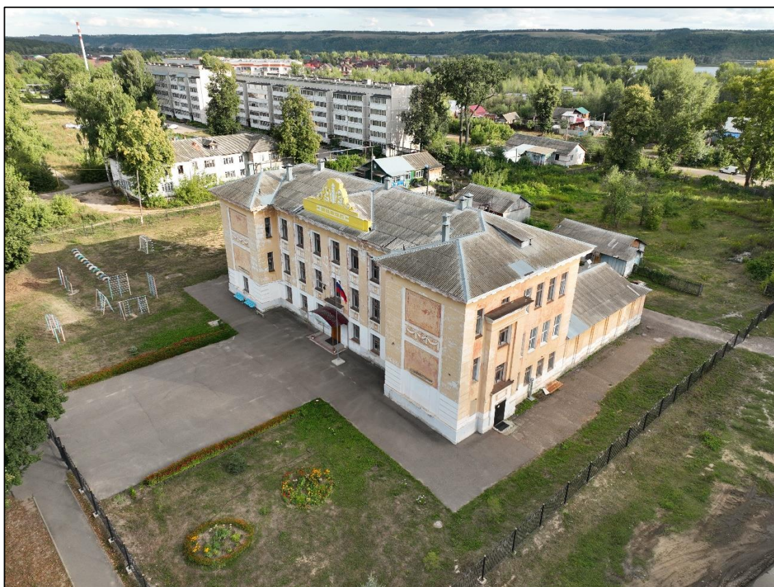
Аэрофотосъемка, точка № 4. Вид на главный (северный) фасад ОКН «Здание школы № 3» и окружающую застройку с юго-востока вдоль ул. Лесозаводская.
