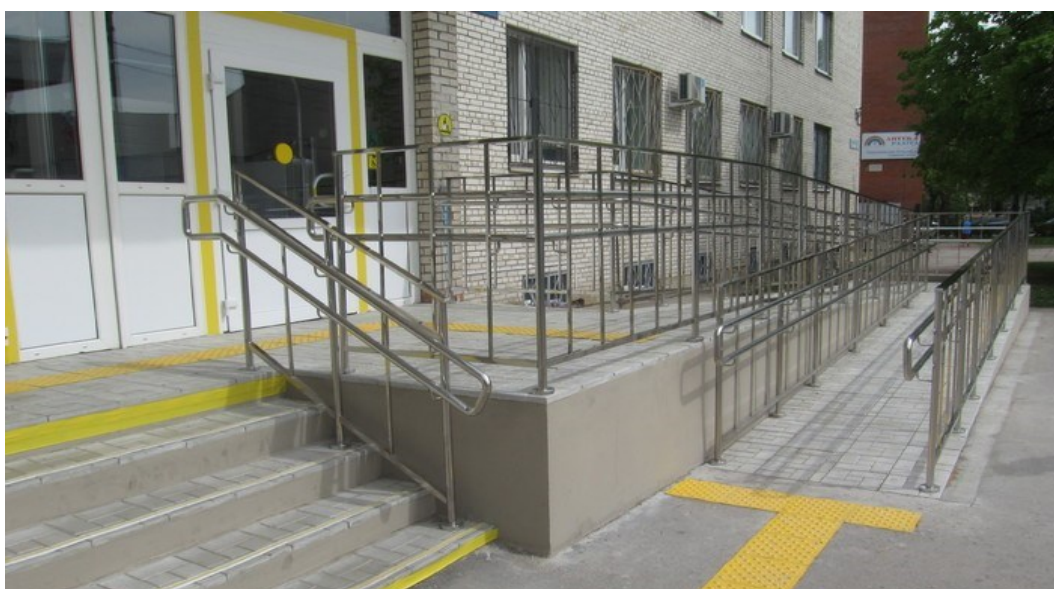
Рисунок 12. Пример организации доступной среды на входе в поликлинику
