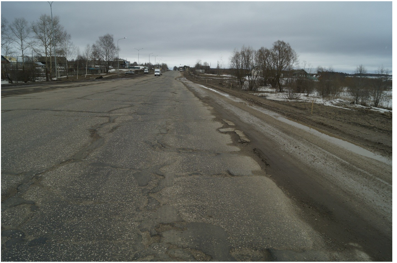
Фото 5. Автомобильная дорога Йошкар – Ола – Уржум на участке км 32+176 – км 33+788 (до ремонта)
