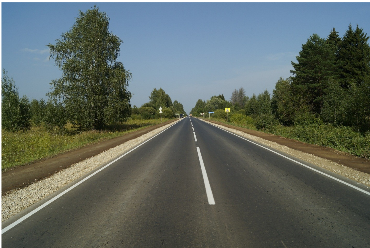
Фото 2. Автомобильная дорога Йошкар – Ола – Козьмодемьянск на участке км 21+000 – км 23+000 (после ремонта)
