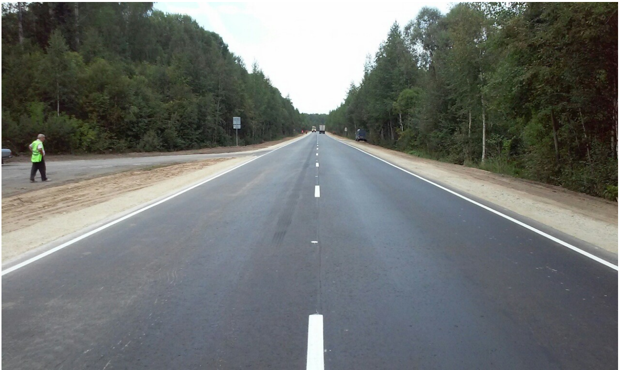
Фото 4. Автомобильная дорога Кокшайск – Красногорский на участке км 3+300 – км 5+000 (после ремонта)
