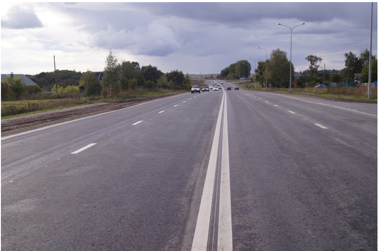
Фото 6. Автомобильная дорога Йошкар – Ола – Уржум на участке км 32+176 – км 33+788 (до ремонта)
