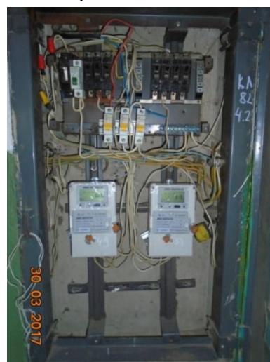
После установки системы
