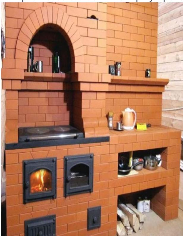
Печи и другие отопительные приборы должны иметь установленные нормами противопожарные разделки (отступки) от горючих конструкций, а на деревянном или другом полу из горючих материалов — предтопочный лист, не имеющий прогаров и повреждений, размером не менее 0,5 x 0,7 м.
